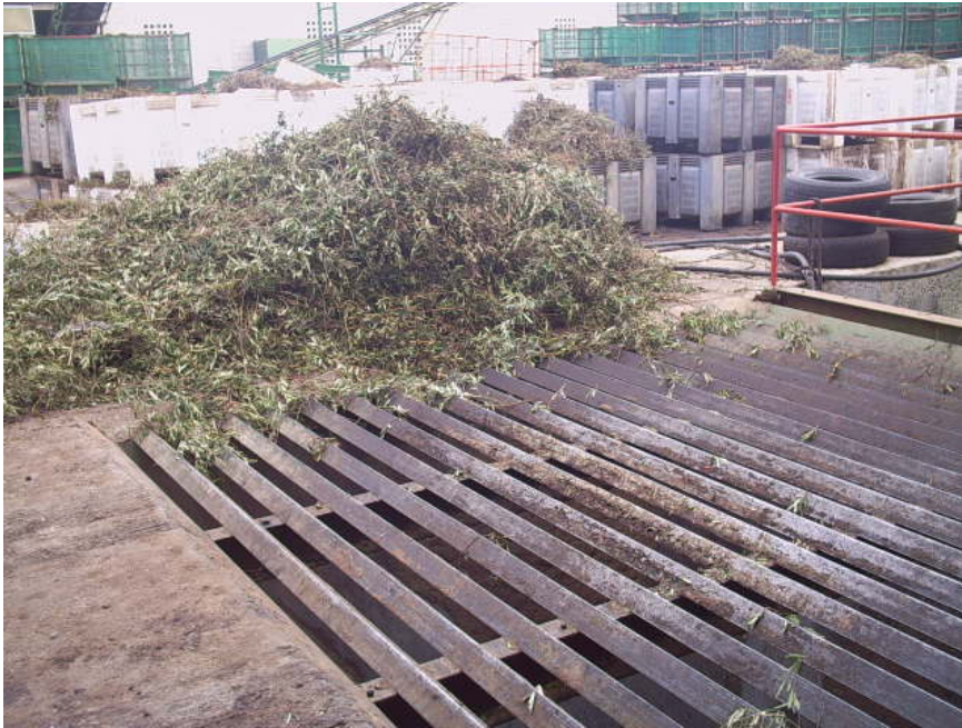
Tolva de recepción
