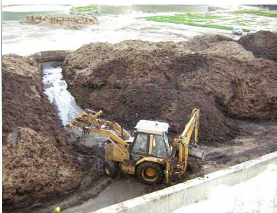
Planta de compostaje de alperujos operativa en Orobaena con el sistema de pilas dinámicas volteadas con pala cargadora
