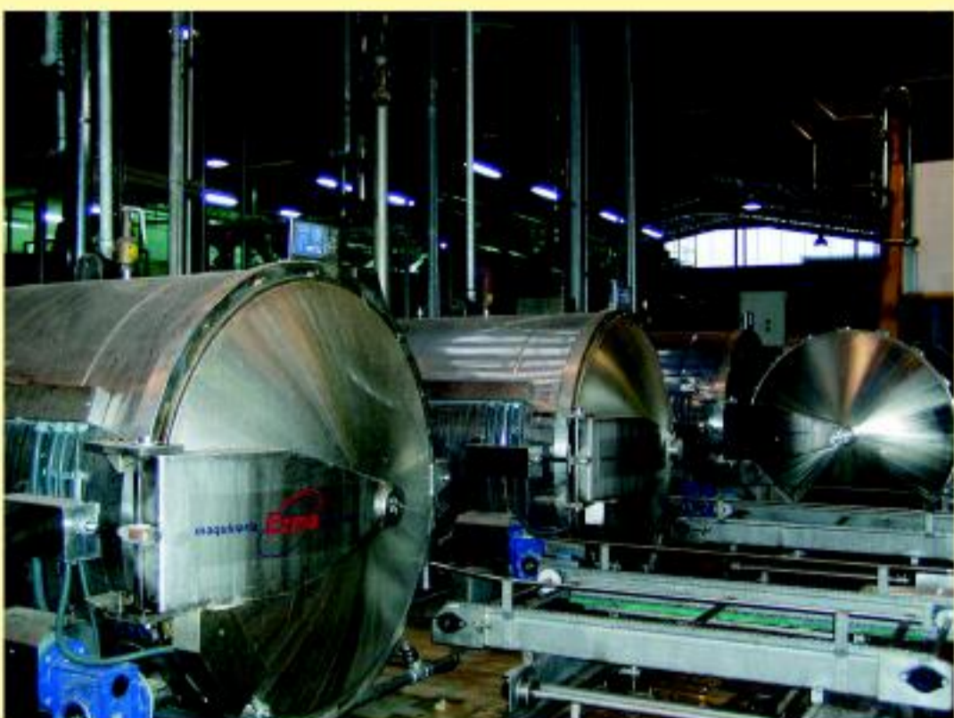
Autoclaves para la esterilización de aceitunas negras enlatadas.
